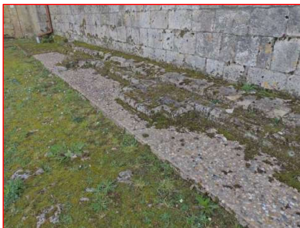
La base primitive plus large du mur nord de la nef mise à jour en 1968.
