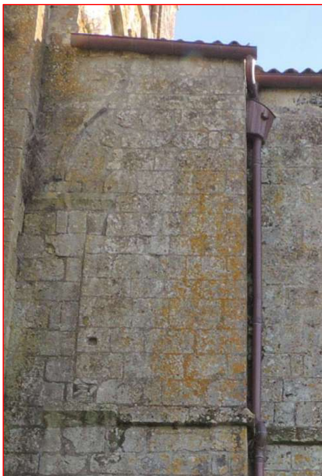
Vestige d'une baie romane murée dernière travée Est du mur Nord de la nef. À cet emplacement, le mur nord de la nef a gardé son épaisseur primitive.
